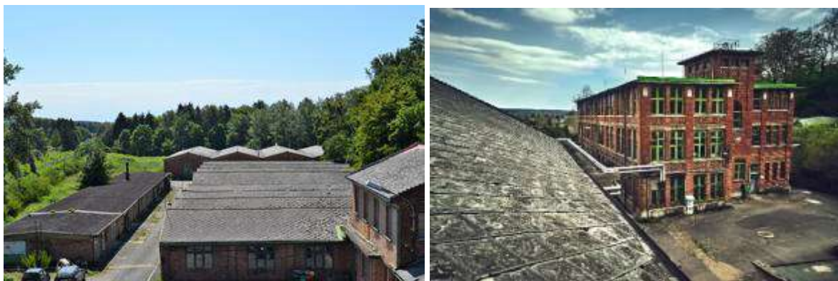
5. ábra. Barnamezős elhagyott üzemcsarnokok és a nemezgyár épülete
